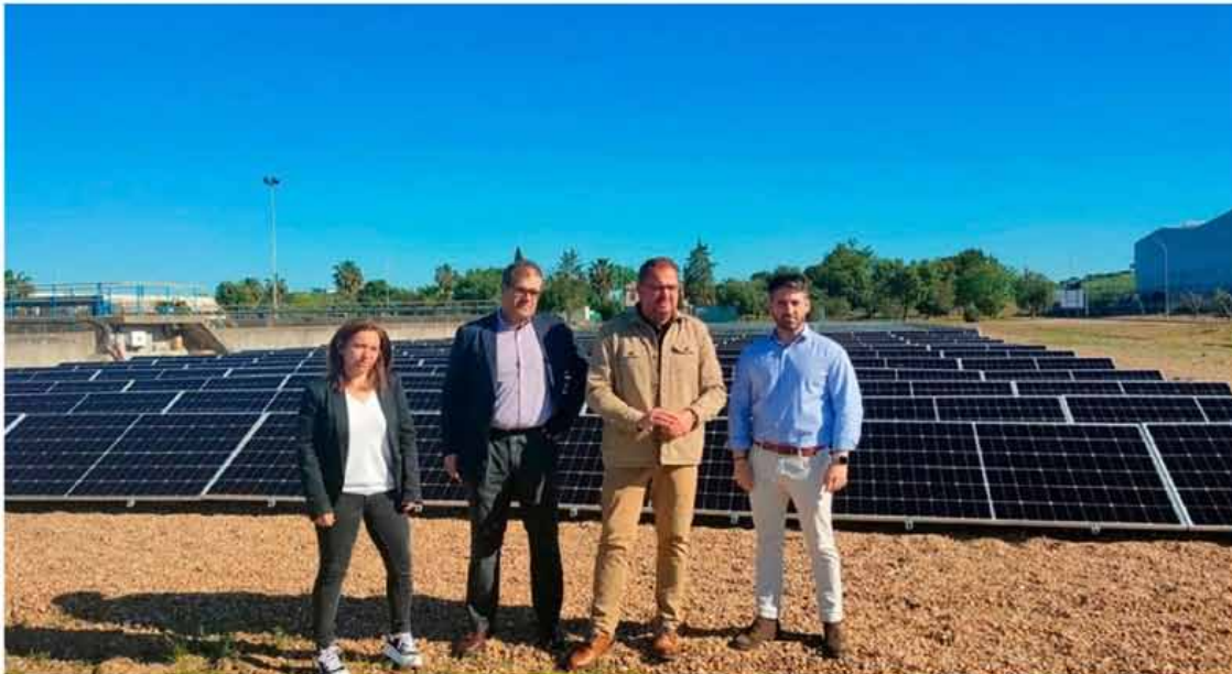
Cubierto 100% consumo energético diurno planta depuradora Mérida energía solar
