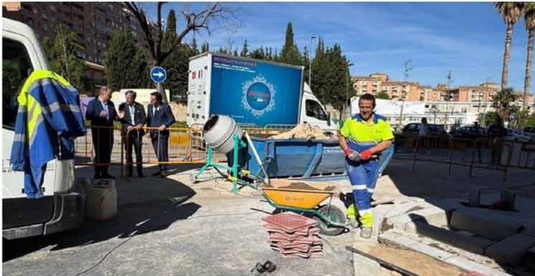
Visita a los trabajos para arreglar el socavón en la avenida de Arjona.
