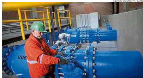
El proceso de cierre de válvulas del suministro de agua debe hacerse lentamente.
